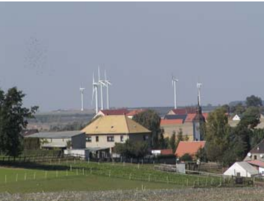
Windkraftanlagen in der Nähe eines Ortes
